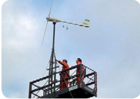
Bornay cuenta con todo el equipamiento para la instalación de sus aerogeneradores. Junto al aerogenerador se suministra una pletina de fijación que es la parte necesaria para fijar su aerogenerador a cualquier tipo de torre.
